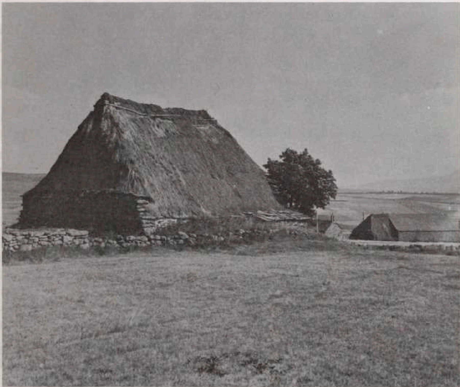
MONTBRAC - La même maison côté nord.
