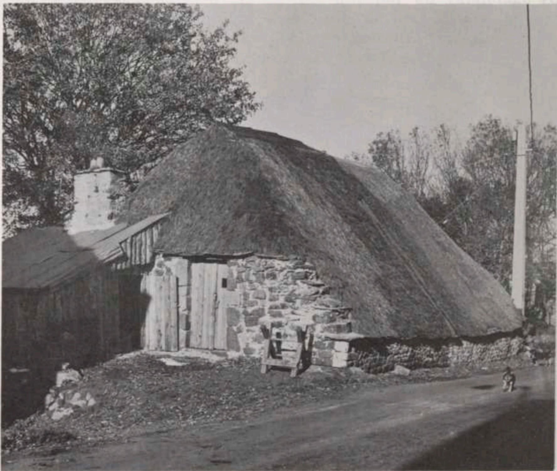
LE BEAGE - Type de maison couverte en genêts des confins de l'Ardèche, dont la toiture est aujourd'hui défigurée.
